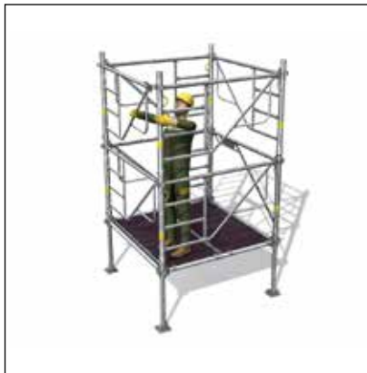
- Einbau von 2 Durchstiegs Elementen von 1 m und Montage der zweiten Ebene
