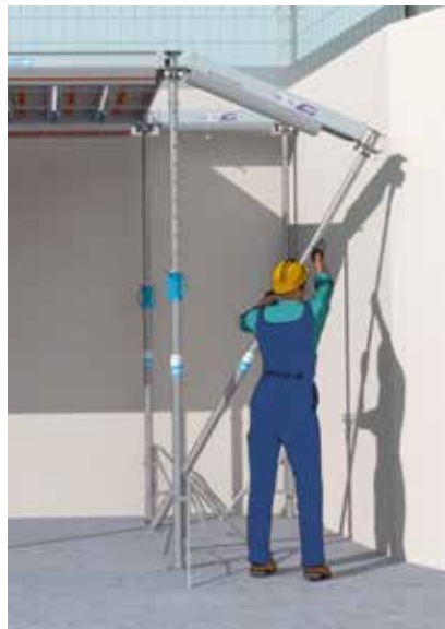
Die ausziehbaren Hauptträger ermöglichen, sich näher an die Wand zu bewegen
