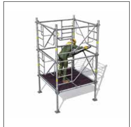
- Einen Belag provisorisch einsetzen. - Einbau des ersten 1 m Durchstiegs elements.
