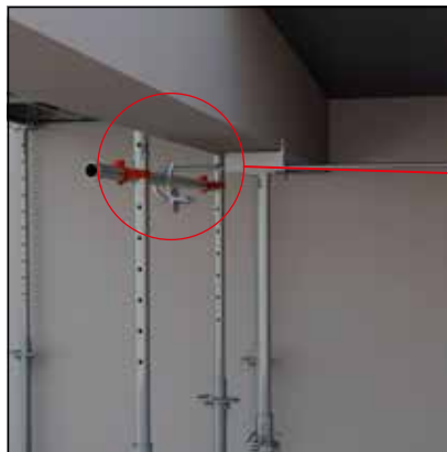
- Die Stabilisierung der ersten Elemente einsetzen. - Wenn sie platziert ist, kann man die Dreibeine entnehmen.
