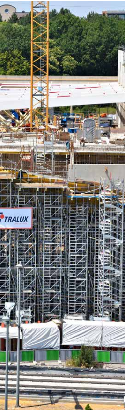
Baustelle: Staatsbibliothek in Luxemburg Kunde: Tralux Ort: Kirchberg
