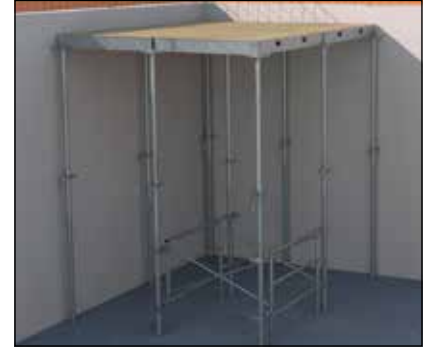
- Ein Rahmen mit Doppelkreuz wird auf die vier ersten Stützen in der Übergangsphase eingesetzt.
